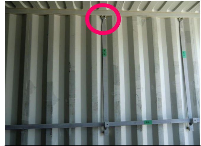
コルゲートの凹に吊棒設置
