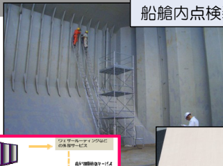
船艙内点検装置
