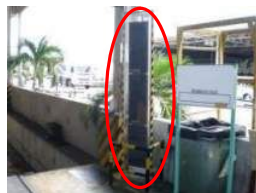
ドックへのRFID リーダの設置
