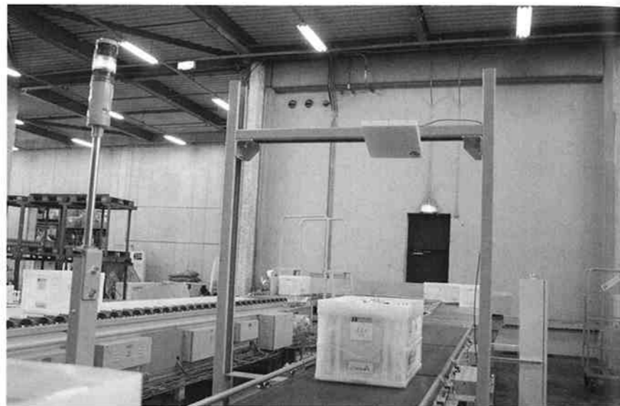
写真-2 分速180mの高速で100%読取りに成功した三菱電機のUHF帯RFIDリーダライタ
