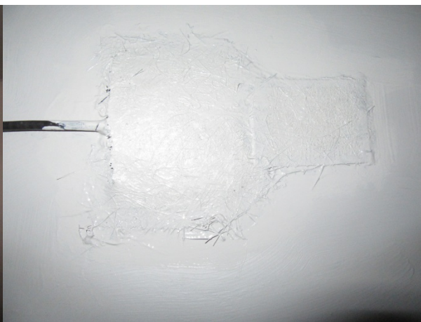
塗装後 (施工時)
