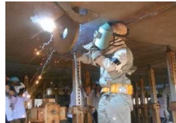
手作業による溶接工程
